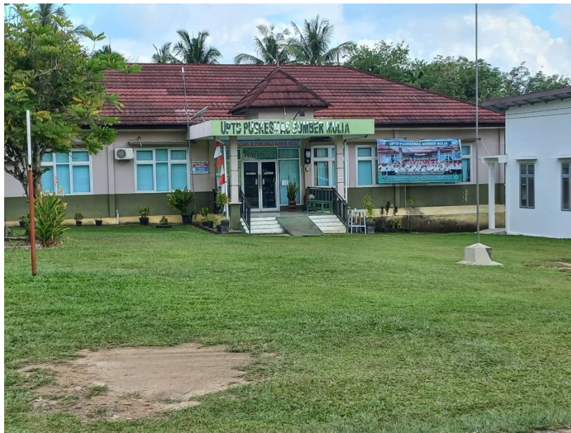
Gambar 2.1 Gedung UPTD Puskesmas Sumber Mulia
